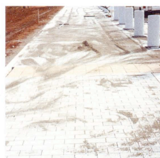
インターロッキング
