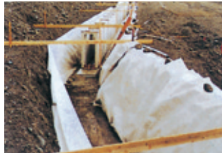
■埋立地側溝（徳島）
