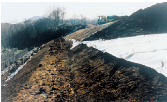
■駐車場盛土（福島）
