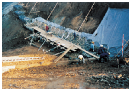
■宅地擁壁裏（福井）
